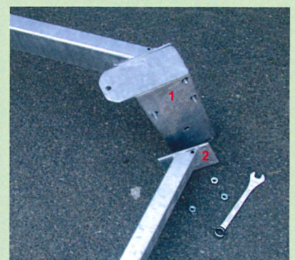
Abb. 5 Montage des Stahlrahmens
