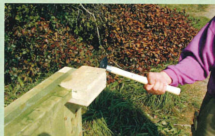
Abb. 9 Transporthölzer entfernen
