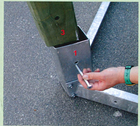
Abb. 6 Montage der Pfosten
