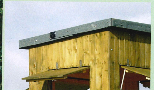
Abb. 18 Überlappung der Schweißbahn
