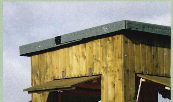
Abb. 19 Überlappung der Schweißbahn
