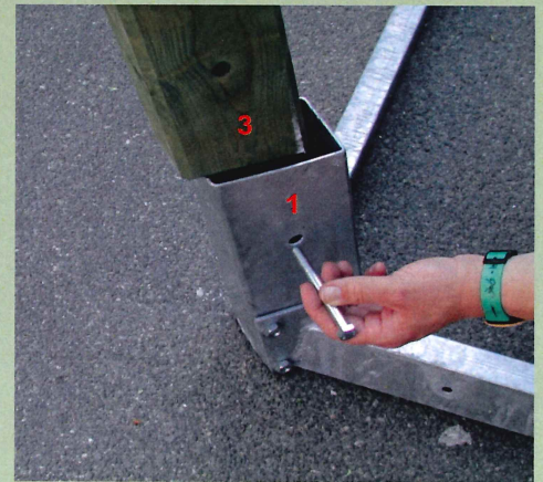
Abb. 6 Montage der Pfosten
