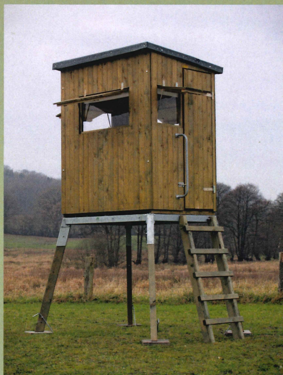
Abb. 21 Fertig montierte Ansitzkanzel mit Bockgerüst
