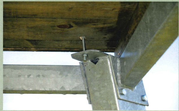
Abb. 11 Ansicht Fußboden von unten
