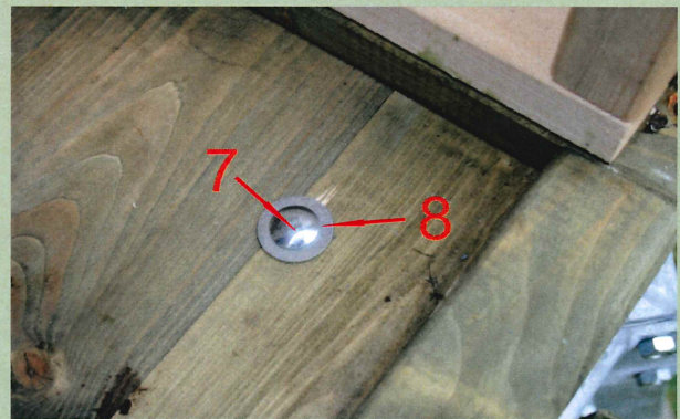
Abb. 12 Ansicht Fußboden innen
