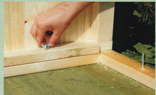
Abb. 13 Montage der Wandelemente auf dem Fußboden
