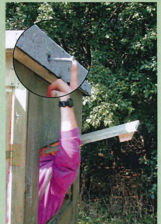
Abb. 20 Dachverschraubung
