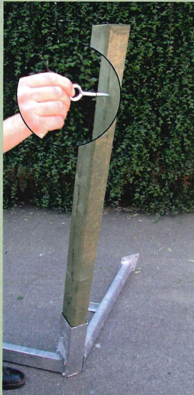
Abb. 6 Montage der Ringschrauben
