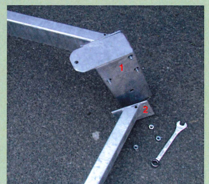
Abb. 5 Montage des Stahlrahmens
