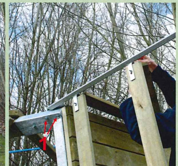
Abb. 12b: Montage Umwehung
