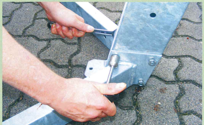
Abb. 5: Montage des Stahlrahmens
