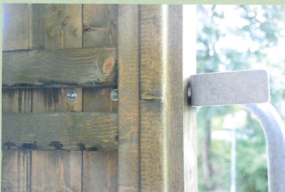
Abb. 20a: Höhe der oberen Befestigungsschrauben
