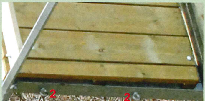
Abb. 13: Augenschrauben montieren
