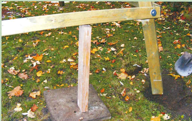
Abb. 14a: Abstützung des Bockgerüsts
