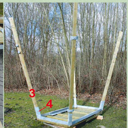
Abb. 9b: Montage der Pfosten
