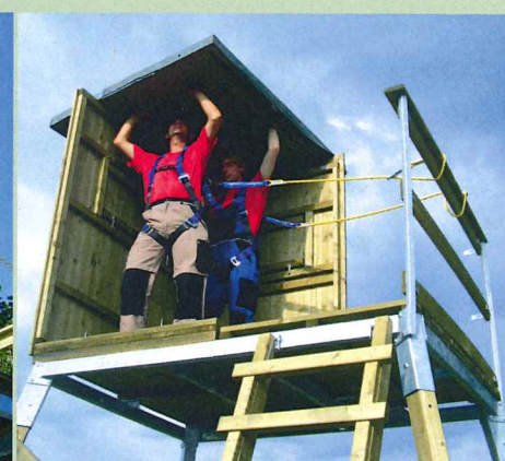
Abb. 16b: Montage der Anstanzkabel
