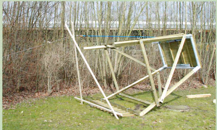
Abb. 11: Aufrichten des Bockgerüsts mit Hilfe eines Seilzuges
