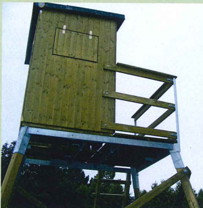
Abb. 19: Fertig montierte Umwehung
