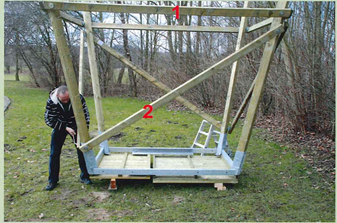
Abb. 10: Montage der Ring- und Diagonalverbände
