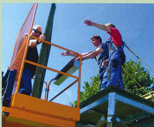
Abb. 16a: Montage mit Arbeitskorb
