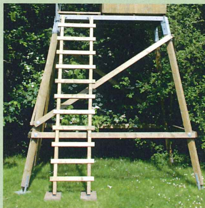
Abb. 15a: Aufstiegsleiter einhängen
