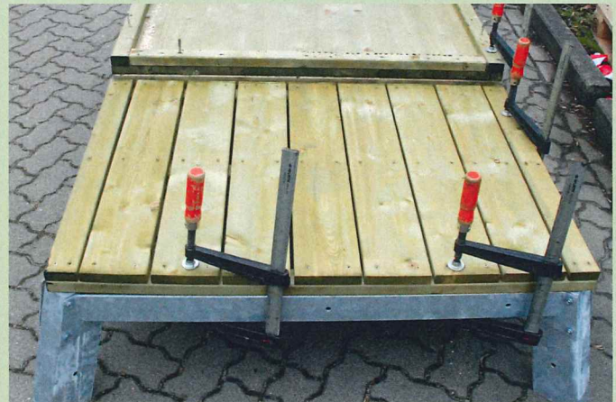
Abb. 8: Sichern von Boden und Podest mit Schraubzwingen
