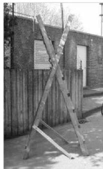
2. Leiter aufrichten, Vorder- und Hinterteil auseinanderziehen. Querriegel herunterklappen und mit dem Vorderteil verschrauben. (M 8x110)
