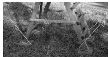
3. Ringschrauben in die Holme drehen und die Erdnägel durch die Ösen, wie im Bild, in die Erde schlagen. **Leiter auf sicheren Stand prüfen !**
