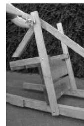
4. Die Stützstreben mit dem Sitzkorb und den kurzen Lehnenstützen mit Flachrundschraube **M 8 x 150** montieren. Dann Lehnenstütze etwa 3cm vor Holmende mit Sechskantholzschraube **8 x 100** befestigen.
